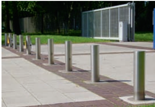
Automatisch versenkbarer Poller mit elektromechanischem Spindeltrieb (Foto: ThyssenKrupp Steel / Bildungszentrum Duisburg)
